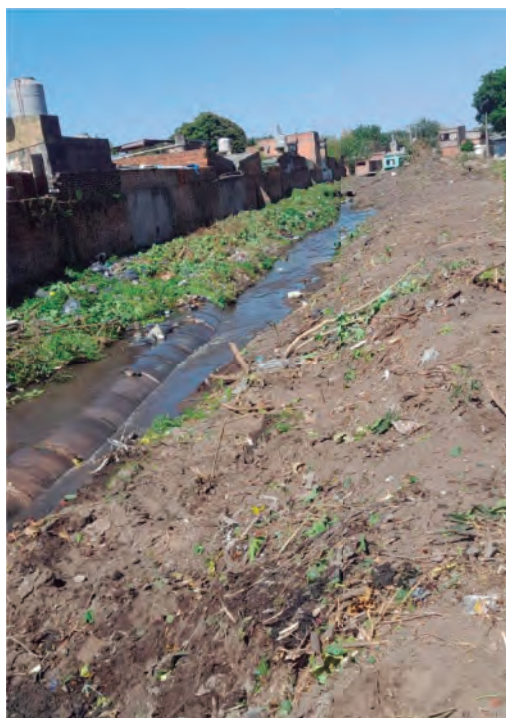
Canal Chivero-Cervezero. Tareas de rectificación de sección, limpieza, desmalezado y levante de residuos
