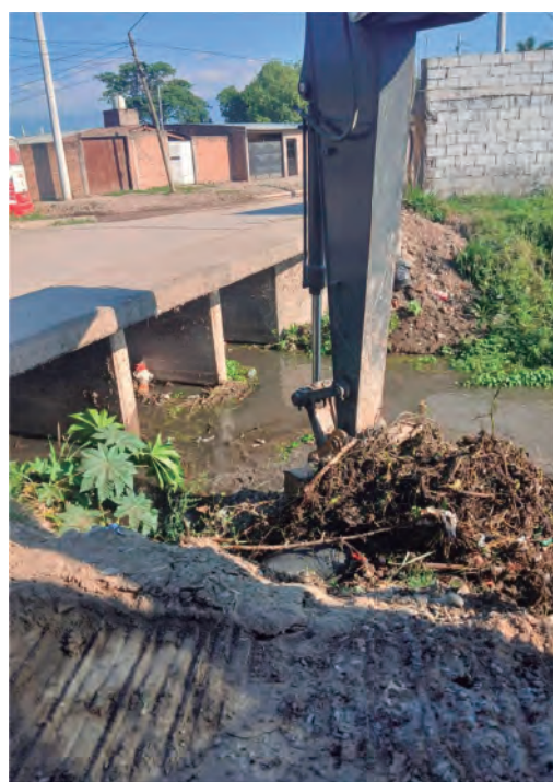
Canal ATE-SMATA-Vial. Tareas de rectificación de sección, desmalezado, limpieza y levante de residuos
