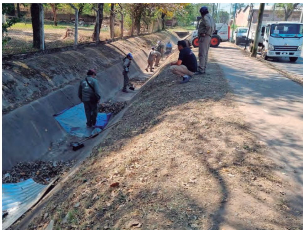
Canal Lince- Silvano Bore. Tareas de limpieza, desmalezado y levante de residuos
